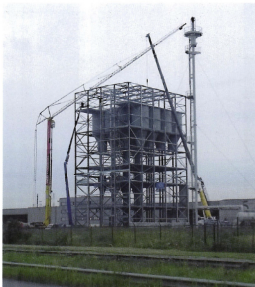
Errichtung der Silo-Konstruktion © van Kerckhove
