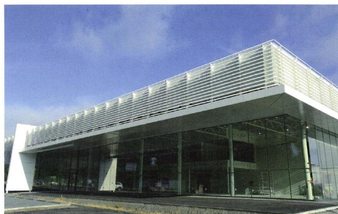
**Bild 1.** Die Stahlteile der Glas-Metall-Fassade des BMW-Autohauses wurden verzinkt und pulverbeschichtet.
