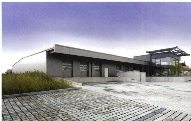
**Bild 3.** Zur weitgespannten Halle für die Produktionsküche zählt auch der Versand mit Vordach, Verladerampe und -toren. (Fotos: Atlas Ward)
