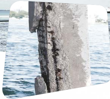
Nicht mit uns Betonabplatzungen durch Korrosion unbehandelter Bewehrung
