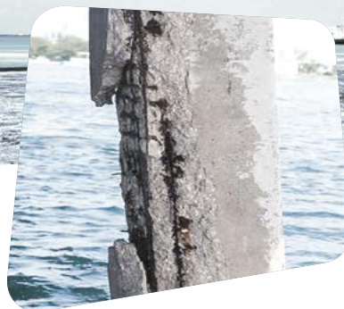
Niet bij ons Betonafschilferingen door corrosie van onbehandelde wapening
