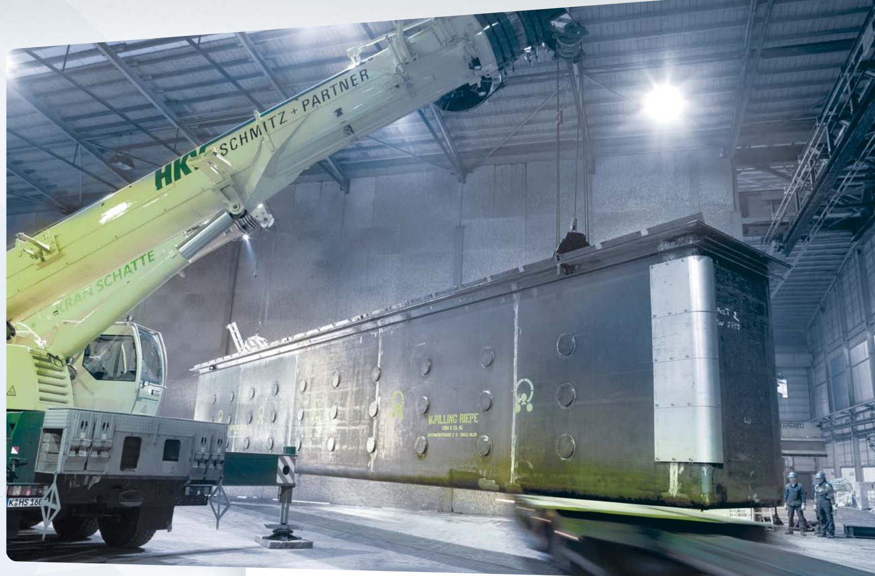
Grote ketels: onderdelen met een lengte tot 19,2 meter kunnen bij ons in één dompelbehandeling worden verzinkt.
