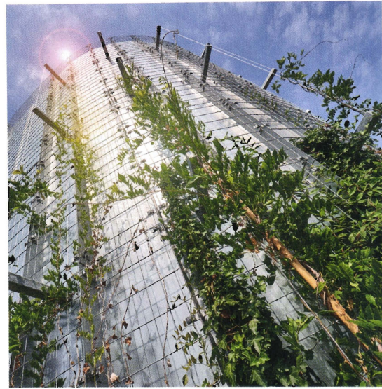
Das Transferium wird energieneutral betrieben und komplett begrünt.
