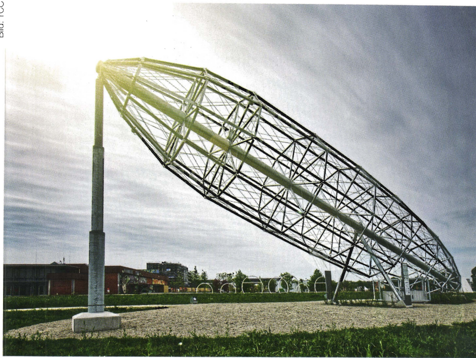
Im aufgebauten Zustand ist die geometrische Konstruktion 20 m lang. Sie wird am Bug um etwa 7,58 m in die Höhe gezogen – so entsteht eine dynamische Gesamtwirkung.
