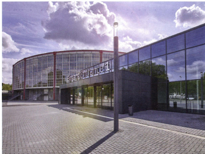
Bild 2 Feuerverzinkung sowie Duplexbeschichtung waren die angewendeten Verfahren.
