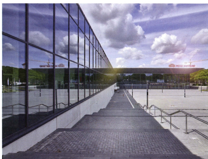
Bild 3 Der Neubau des Eingangsbereichs der Westfalenhalle übertrifft alle bisherigen Baumaßnahmen an dem Messegebäude.
