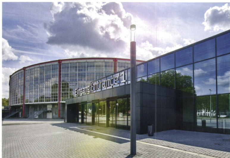
Der neue Eingang zu den Westfalenhallen Dortmund.
