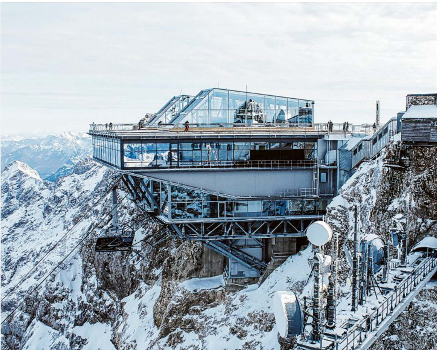
Die Zugspitzbahn fährt unzählige Besucher den Berg hinauf – da dürfen sich in der Verarbeitung keine Fehler einschleichen. Das Kreuztaler Unternehmen Coatinc PreGa war jetzt für die Veredelung der Bahn verantwortlich. Foto: Bayerische Zugspitzbahn Bergbahn AG
