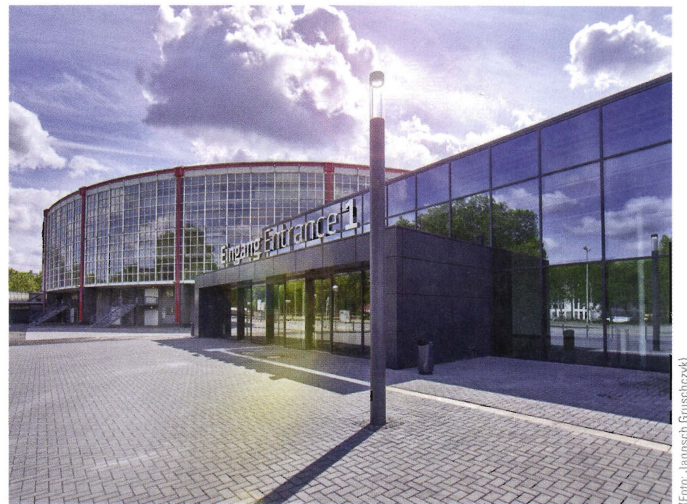
Bild 2 Westfalenhalle Dortmund: Die Stahlbauteile des neuen Eingangsfoyers zur Messe wurden von Coatinc Bochum verzinkt, um sie nachhaltig vor atmosphärischen Einflüssen zu schützen
