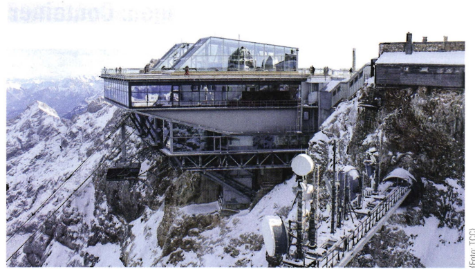
Bild 1 Zugspitzbahn: Das Projekt zeigt auf, dass auch höherfeste und hochfeste Verbindungen mit der Hochtemperaturverzinkung veredelbar sind
