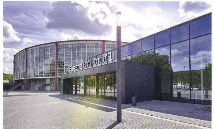
**Bild 2.** Westfalenhalle Dortmund: Die Stahlbauteile des neuen Eingangsfoyers zur Messe wurden von Coatinc Bochum verzinkt, um sie nachhaltig vor atmosphärischen Einflüssen zu schützen (Foto: Janosch Gruschczyk)
