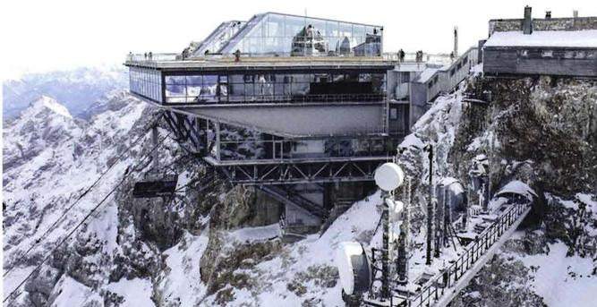
**Bild 1.** Zugspitzbahn: Das Projekt zeigt auf, dass auch höherfeste und hochfeste Verbindungen mit der Hochtemperaturverzinkung veredelt sind (Foto: TCC)
