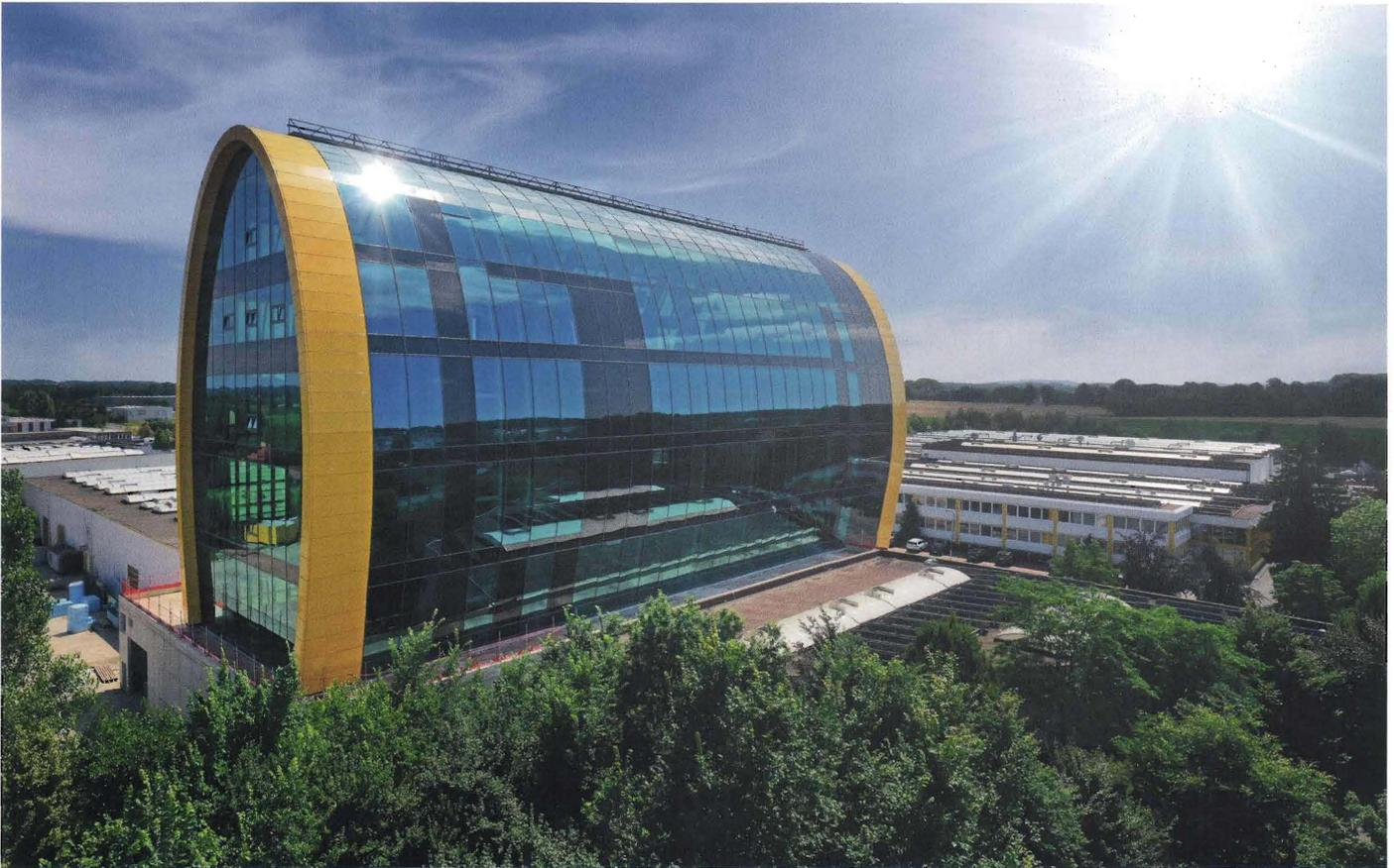
Das neue Innovationszentrum von Spartherm Melle: Rund 90 Tonnen Stahl waren für das Gebäude zu verzinken.
