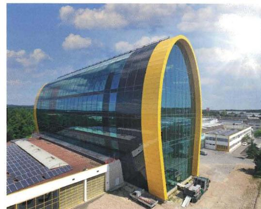
Coatinc24 lieferte 1.900 Quadratmeter Pulverbeschichtung in Feinstruktur und just in time. | Fotos: The Coatinc Company//Janosch Gruschczyk
