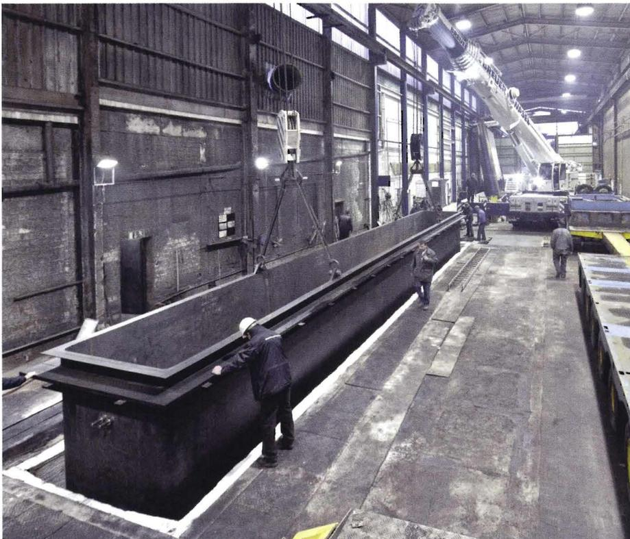
Einbau des Verzinkungskessels mit den Maßen: 16,2 x 1,7 x 2,4 m (Länge x Breite x Tiefe).
