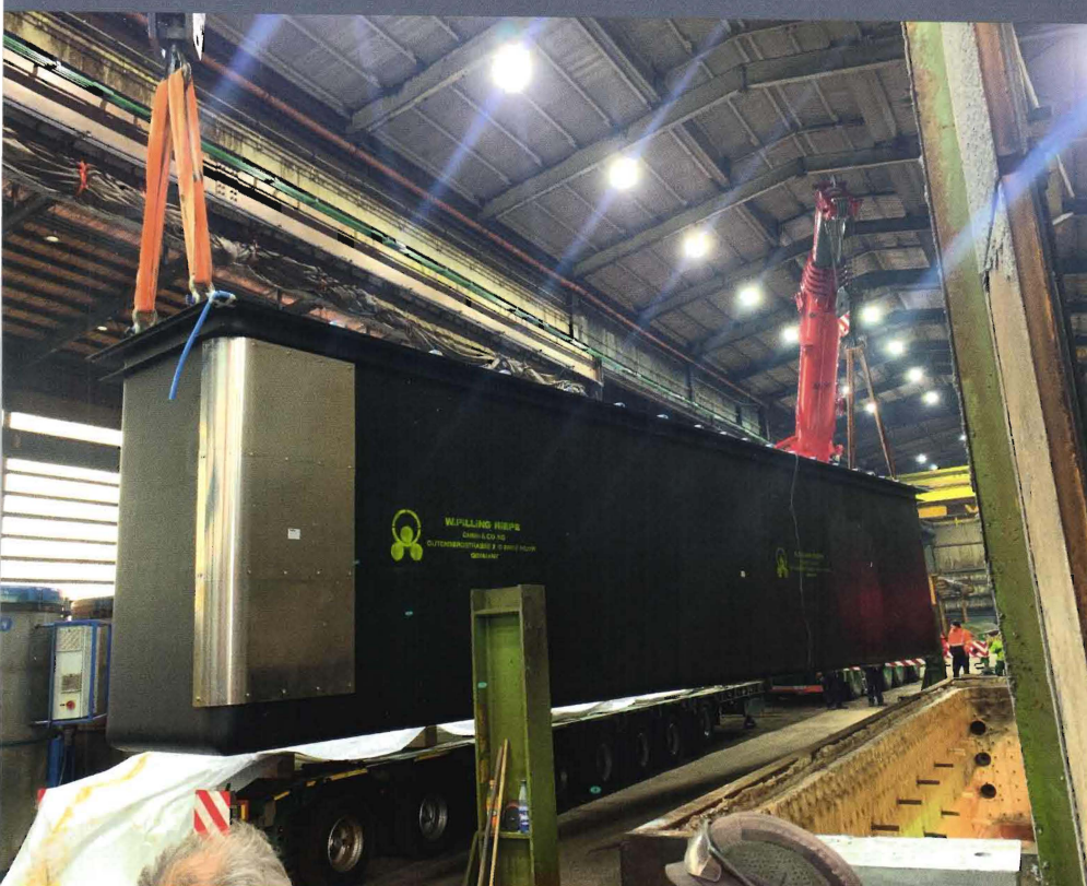
Einbau des neuen Feuerverzinkungskessels zum Jahreswechsel 2021/22 | Fotos: TCC
