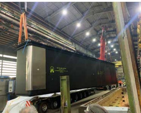
Einbau des neuen Kessels zum Jahreswechsel
